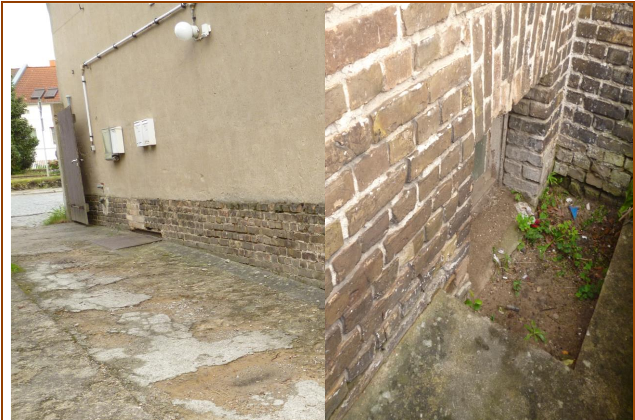
Abb. 3 verschlossene Kelleröffnungen: links auf der Nordgiebelseite, rechts Längsseite Westseite
