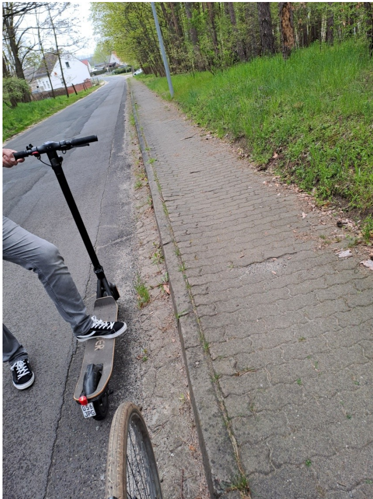
Gehweg am Horstweg durch Wurzeln verursachte Stolperfallen/ Gefahrenstellen
