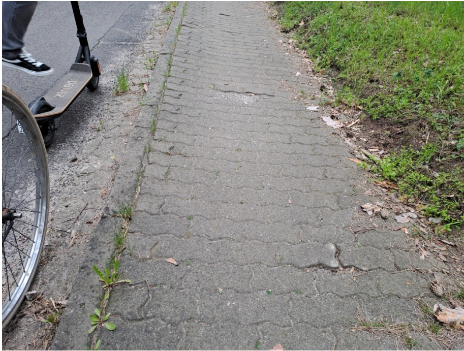
Gehweg am Horstweg durch Wurzeln verursachte Stolperfallen/ Gefahrenstellen
