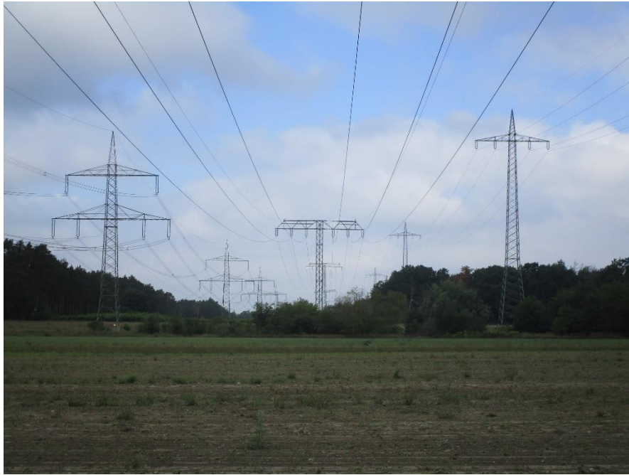
Abbildung 4 V. l. n. r.: 380-kV-Leitung der 50Hertz Transmission GmbH, 110-kV-Leitung der E.DIS AG und 110-kV-Leitung der DB AG, aufgenommen am Rand des Plangebietes mit Blick Richtung Westen
